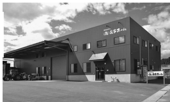
平成 26 年新設 精米工場・事務所外観
