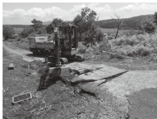
写真 地区保全工事作業請負
