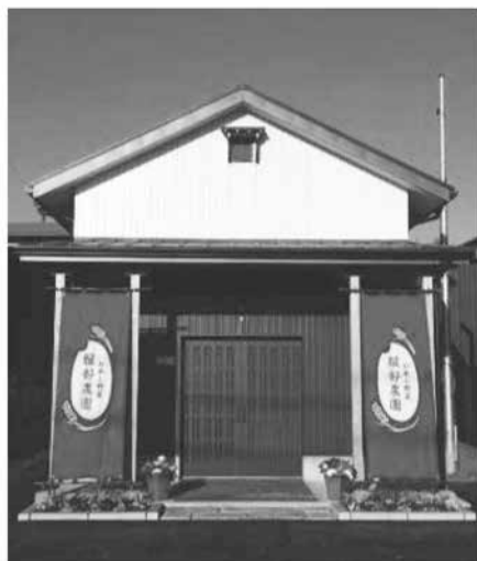
平成 27 年 事務所兼直売所を整備
