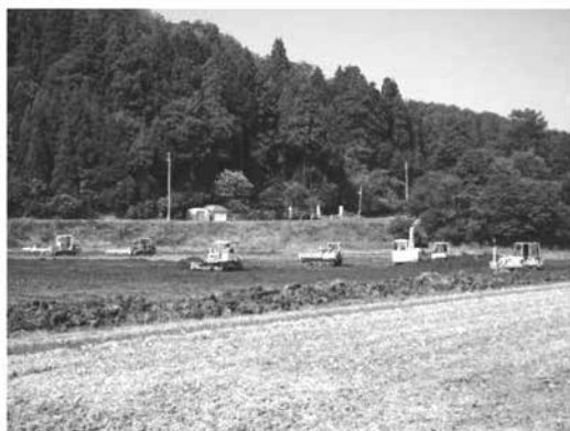
写真 ほ場整備の様子
