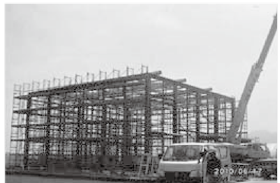
図4 建設中の乾燥調製施設～ピンクの鉄骨～
