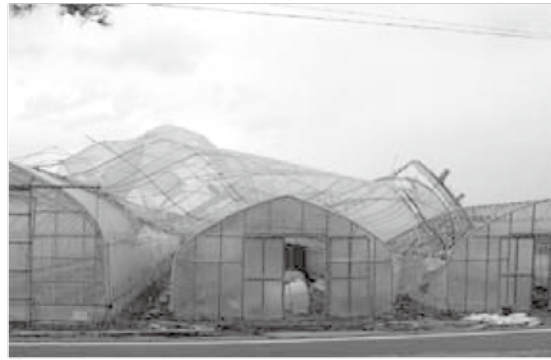
図3 ダウンバーストによるハウス倒壊
