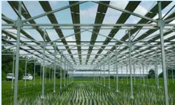
▲発電パネルの間隔は1.2m程。遮光率は32%で十分な光量を確保
