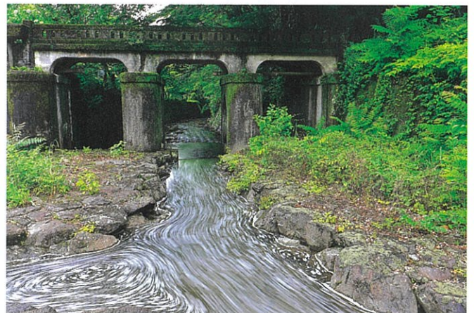
まぜえんてい 間瀬堰堤管理橋
