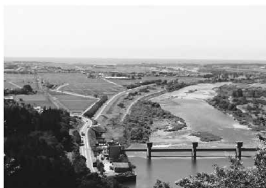
写真 1 荒川の上流から荒島集落を望む
