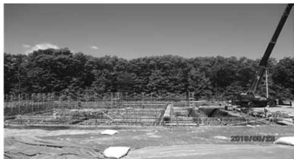
建設中の吾妻第二農場 浄化槽
