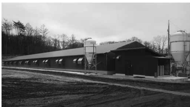
完成した吾妻第二農場 離乳舎
