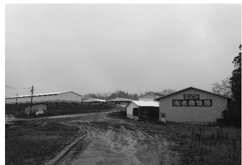
肉用牛拡大により建設した新しい牛舎
