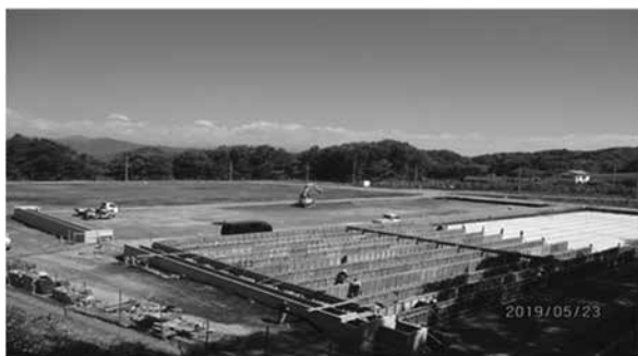
建設中の吾妻第二農場 肥育舎
