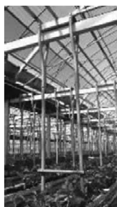
図3 左：障害物のない底面 右：安定性を確保する 松葉つえ型パイプ
