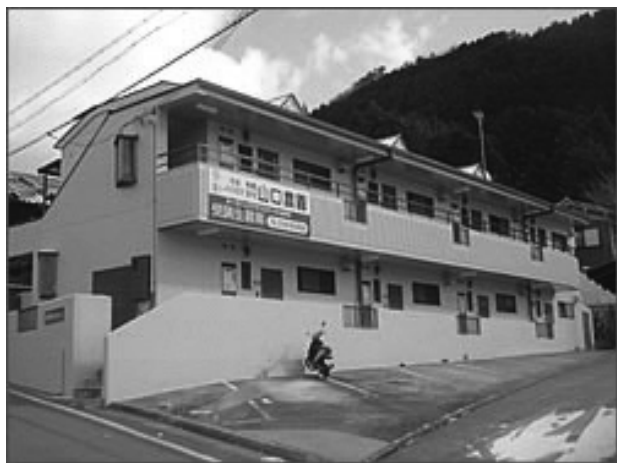
研修生や従業員のための寮も整備
