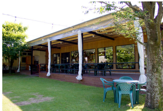
写真5 直売所兼レストランの外観
