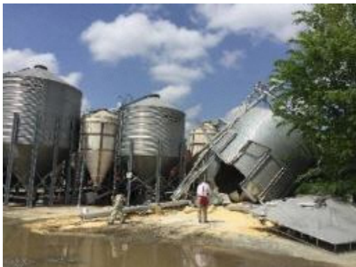
写真 21 熊本地震の被害
