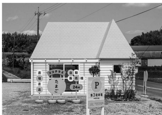
写真12 自動販売機外観
