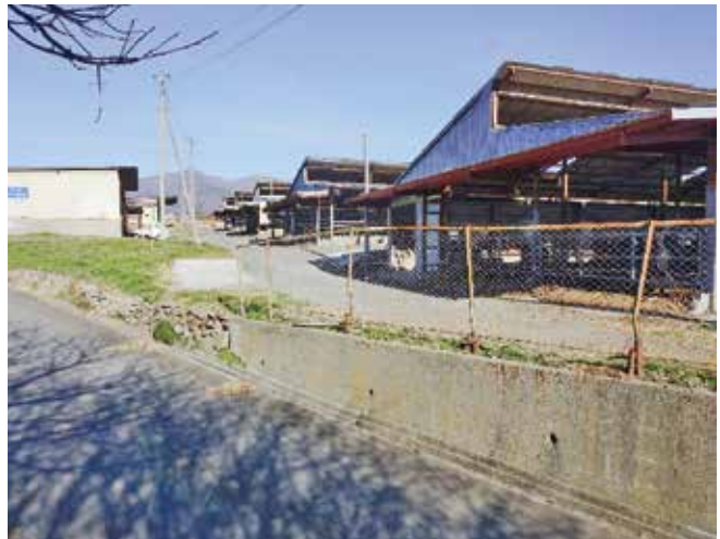
写真7 牛舎が5棟連なる旧畜産団地
