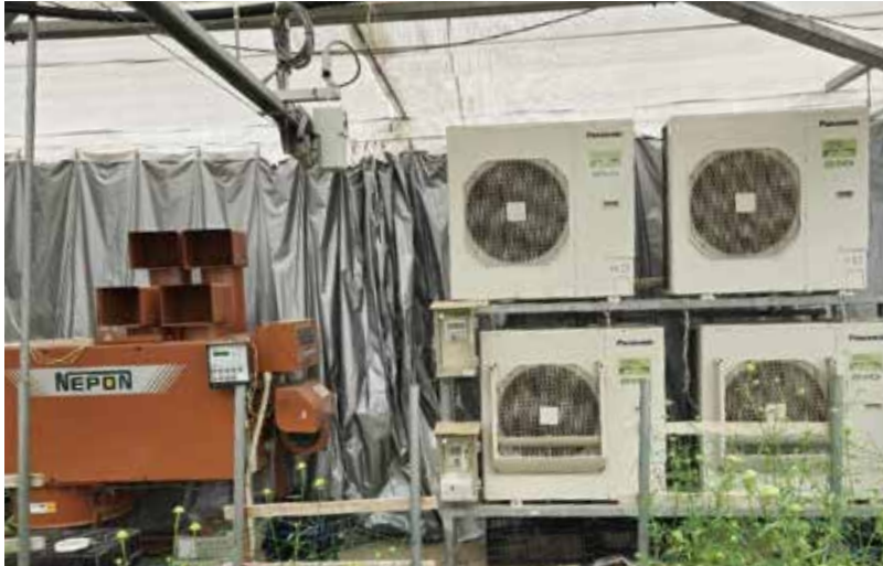
写真5 加温機とヒートポンプの併用によるハイブリッド加温
