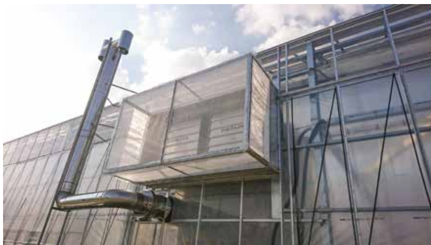
写真10 外気導入換気部分
