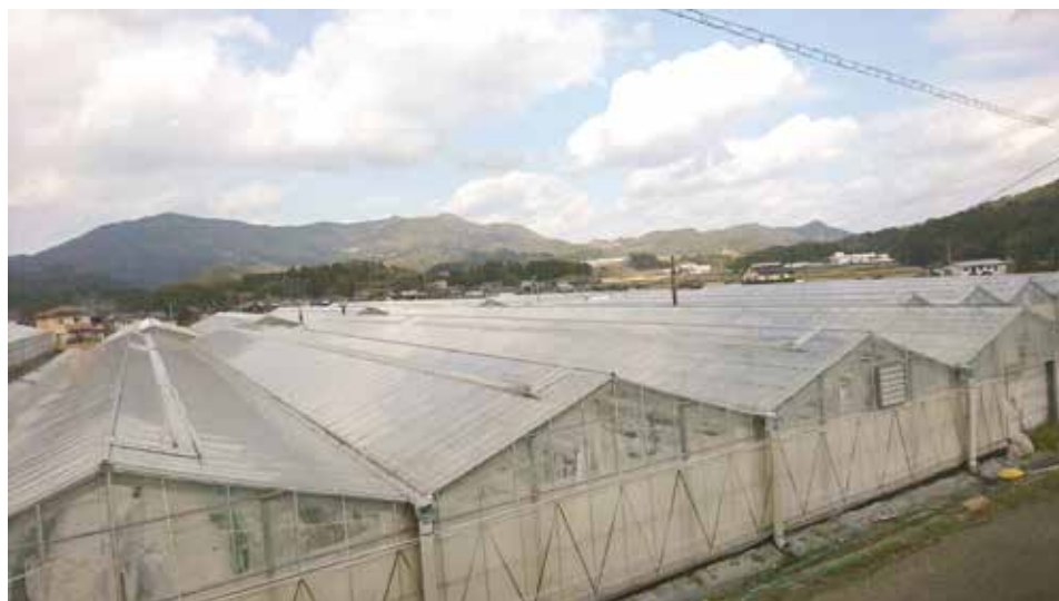
写真1 硬質フィルムハウスの導入
