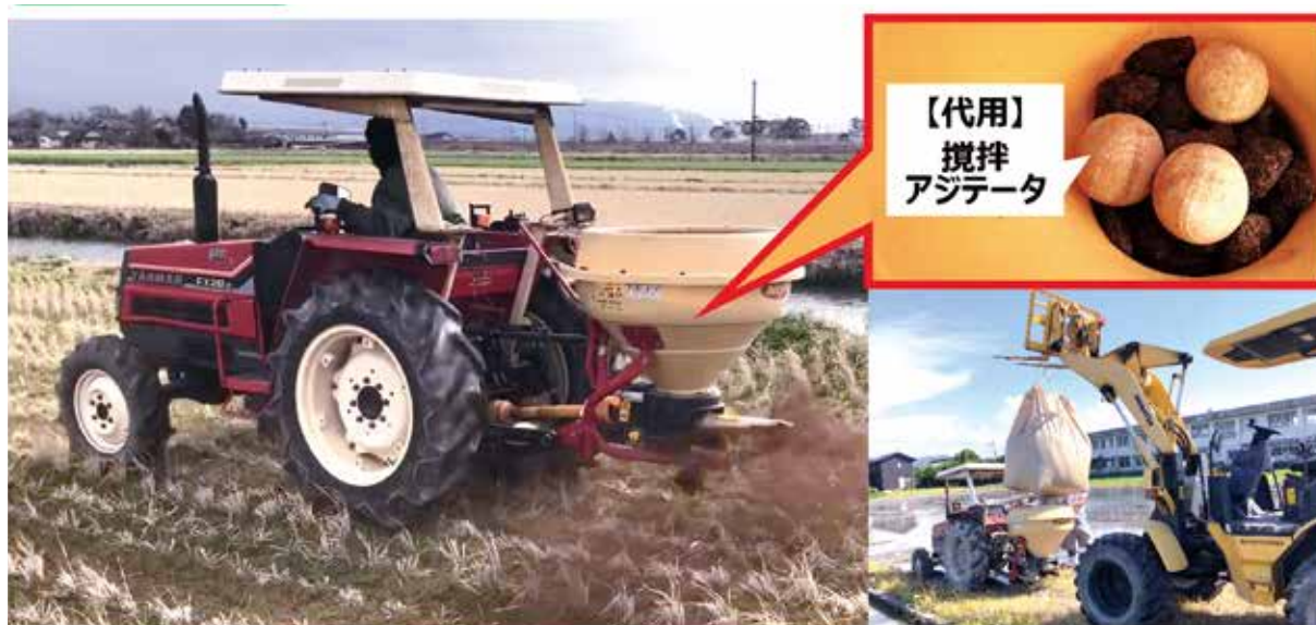
写真3 ブロードキャスターによる「フレコン入り堆肥」散布試験
