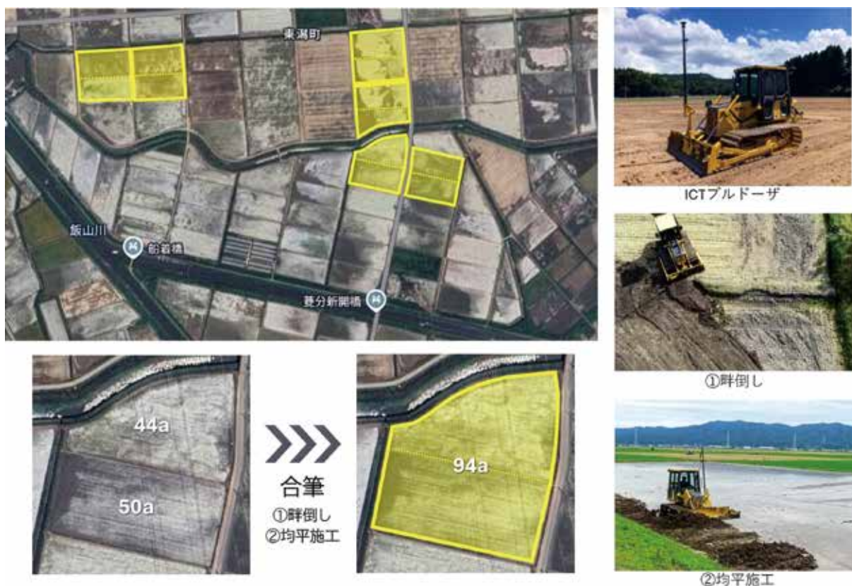
図5 ほ場の大区画化の一例（ICTブルドーザを活用した大区画化）
