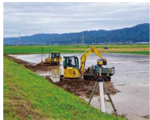
写真6 被害を受けた農地の復旧工事
